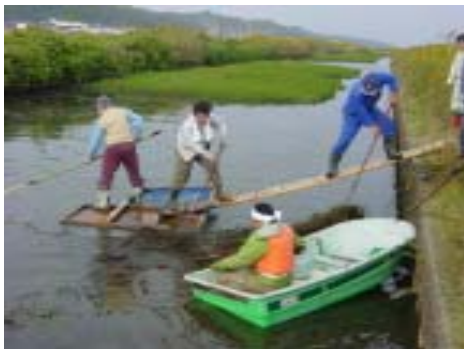
地点1西部承水路での草取り作業の様子
