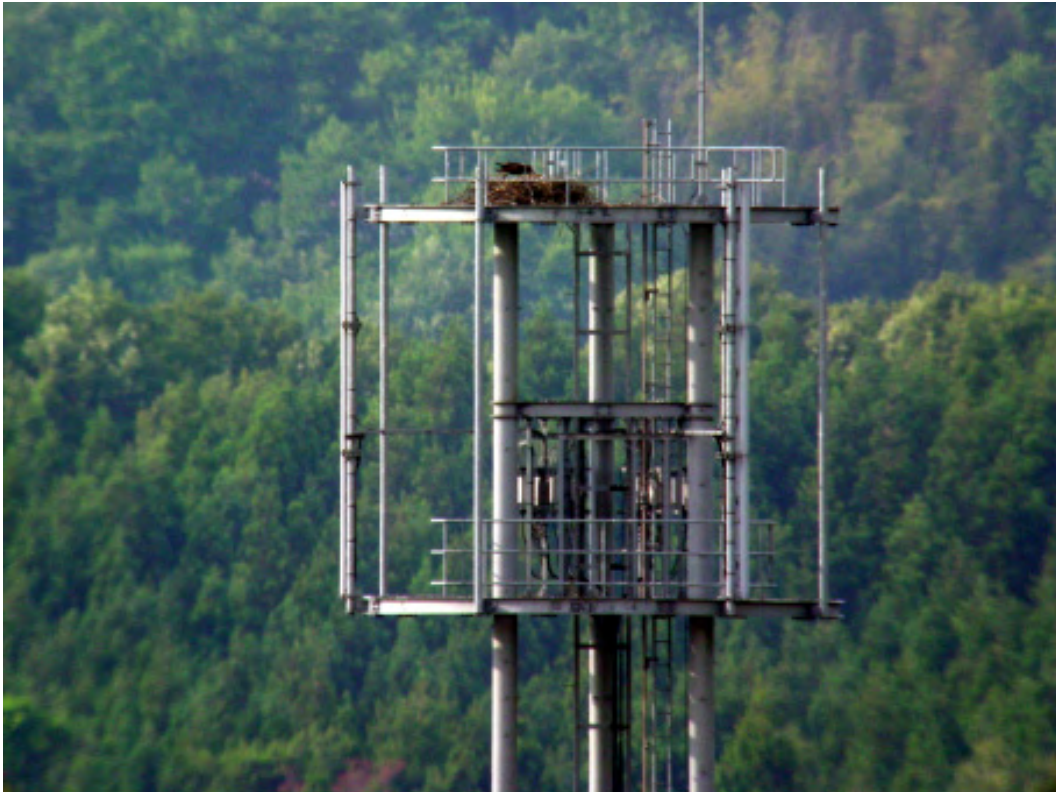
鉄塔の上につくられたミサゴの巣。写真は2004年の6月。巣が撤去されたためか、その後ここでの営巣はみられない。
