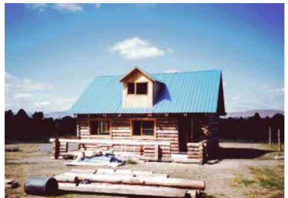
ホルフレー農場 建設中の環境研修施設
