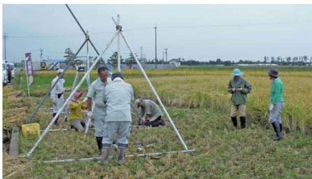
まず縦に単管を立てます。脚立の上に立ち、掛矢で上から打ち込みます。今年は縦に4本立てました。次に倒れないように斜めに単管を2本ずつ組み入れます。そして、斜めの単管が地面につく所で、沈下防止用の単管を組み入れます。縦にした単管を中心に、地面上に直角三角形が2つできます。これをあと3つ作り、その間を横にした単管で、上と真ん中あたりをつなぎました。最後は両端の縦の単管にさらに斜めに単管を足して倒れないようにします。そして横に入れた単管の間に縄をわたして完成です。
