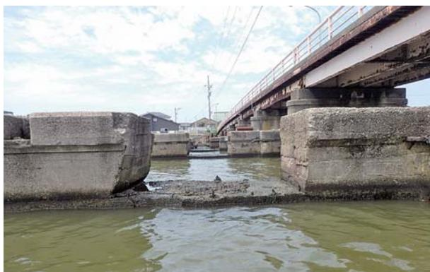
写真9 新川橋に残っているゲート式の防潮水門跡
