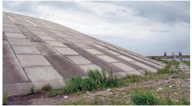
巨大防潮堤を下から見たところ
