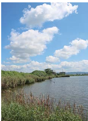
金沢港防潮水門
