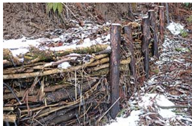
上の写真がしがらみ。大小の枝や稲わら、落ち葉を絡ませ組み上げたもの。土が崩れるのを防ぎ、また土中の微生物を元気にする仕組み。
