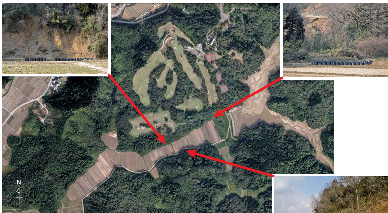
2023年の豪雨により土砂崩れが起きた事例（津幡町能瀬川流域） 里山の利用形態も含めて検討する必要がある。（ベースの空中写真は国土地理院電子国土(web)、現地の撮影は2024年3月14日）
