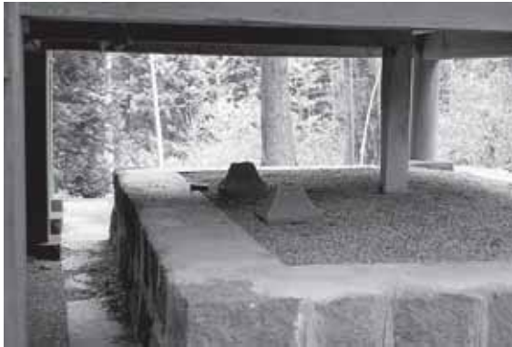
写真 4. 上大田白山神社奥殿縁の下の五輪の塔部分（火輪）2 基。
