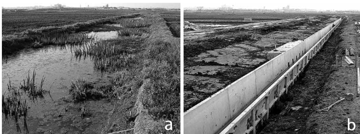
図 4. 河北潟におけるほ場整備の例. かつて稲を積んだ舟が行き来した舟入川（左）が、ほ場整備によりコンクリート水路に変わっていく様子（右）.
