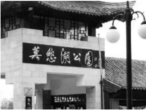
写真1 . 莫愁湖公園 大通りに面した正門
