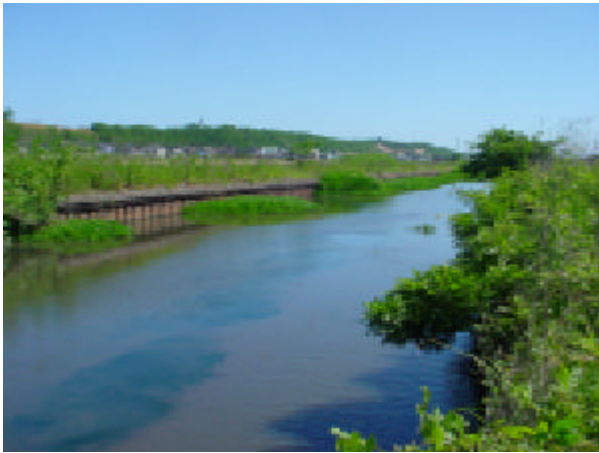
写真1 . 西部承水路の様子 (2002年6月).
