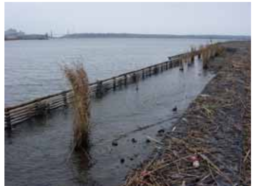
写真2. 堤防の改修工事に伴って整備された護岸 . 防波堤の内側にヨシが植栽された .
