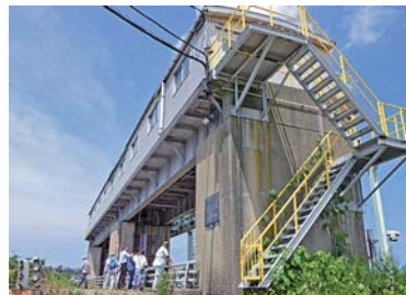
金沢港防潮水門(2024年8月6日)。
