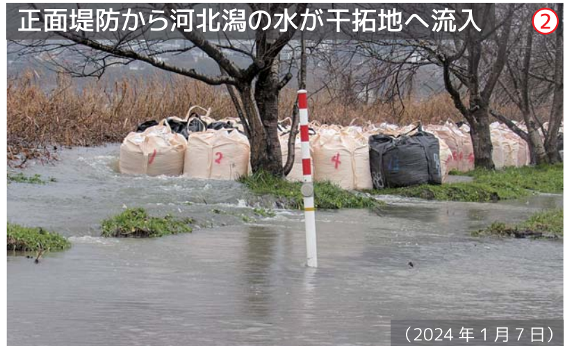
沈下した正面堤防（2024年1月7日）
